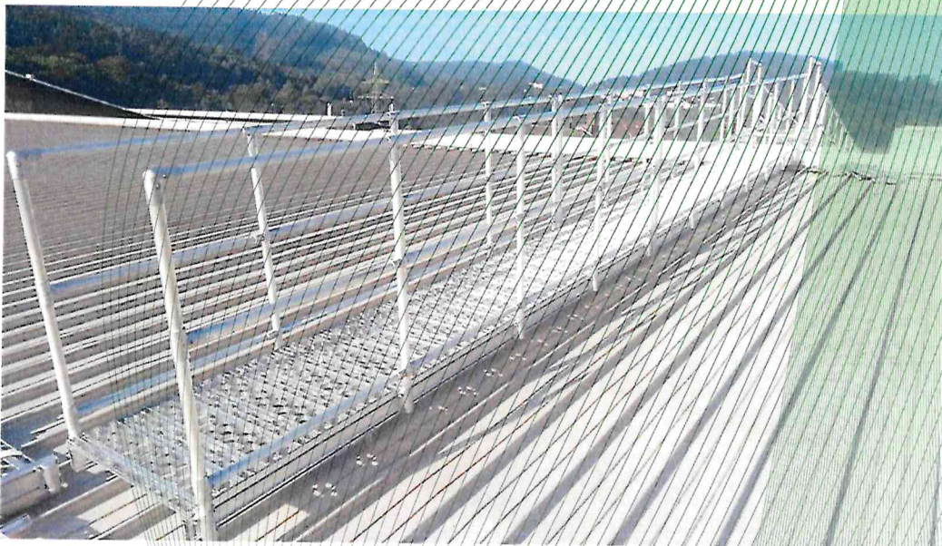
Bild 1: Rettungsweg, Typ: Laufsteg für Rundbördelfalzprofile, montiert auf Rundbördelfalzprofilen
